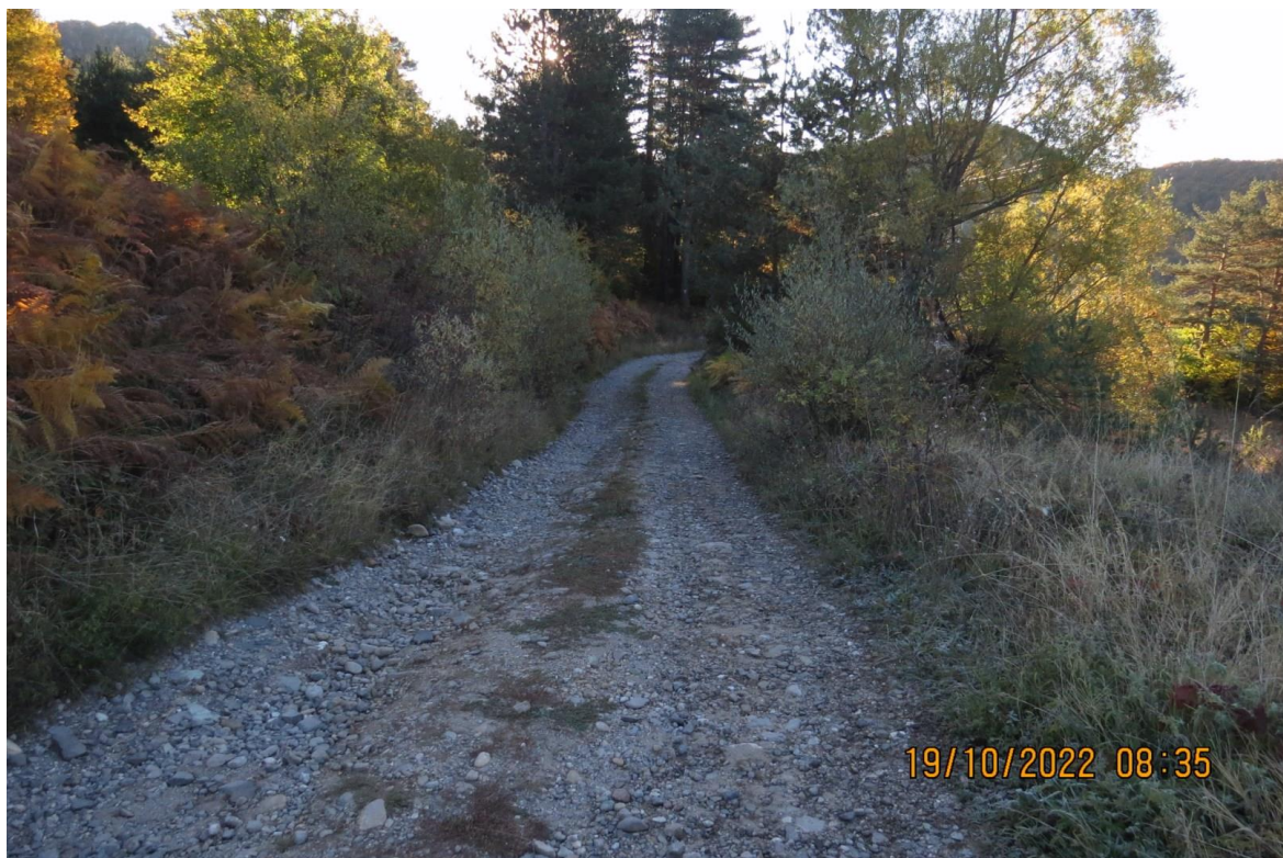
Снимка 4. Път в ПИ 49151.10.104, водещ до ПИ 49151.10.28
